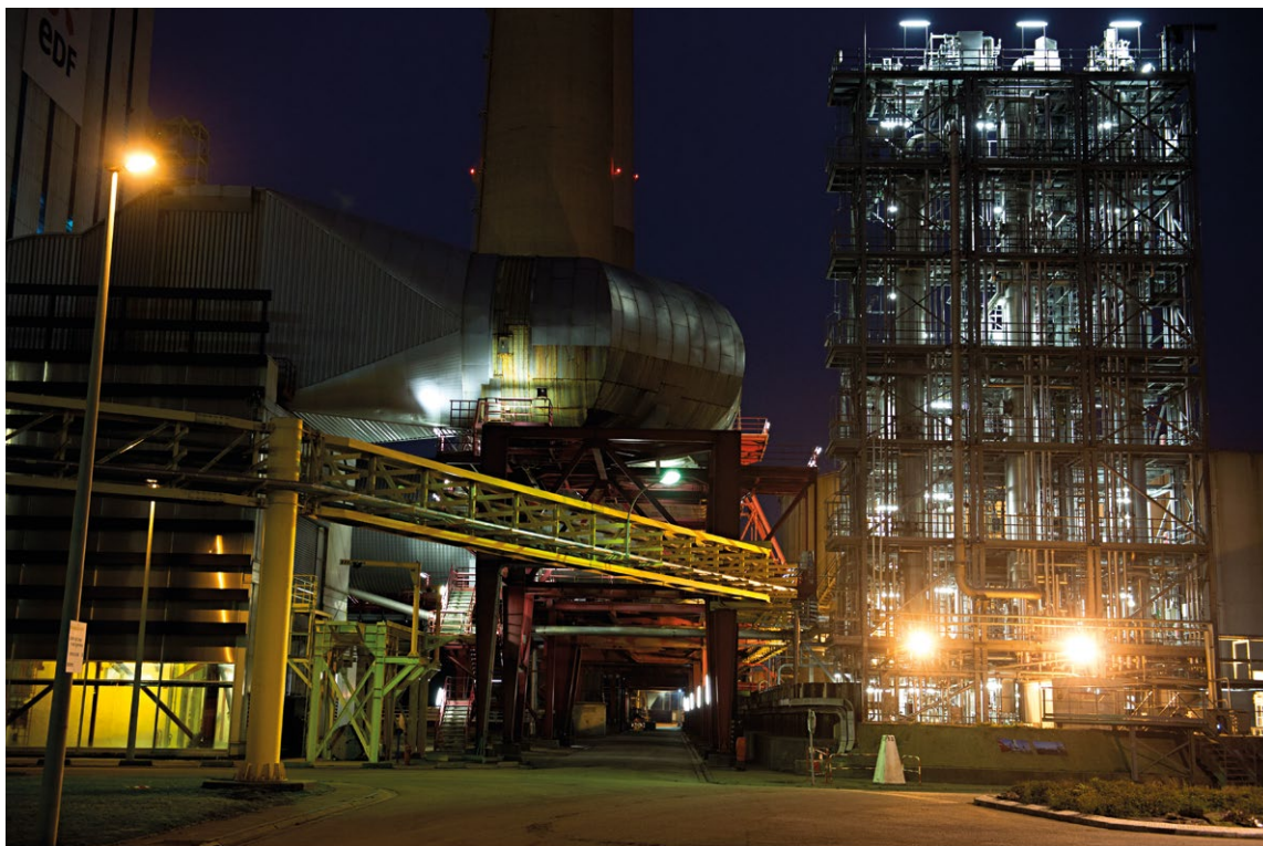
Pilote de captage de CO 2 par procédé aux amines (1t/h), sur le site de la centrale charbon d'EDF au Havre, en France, testé en 2014.
